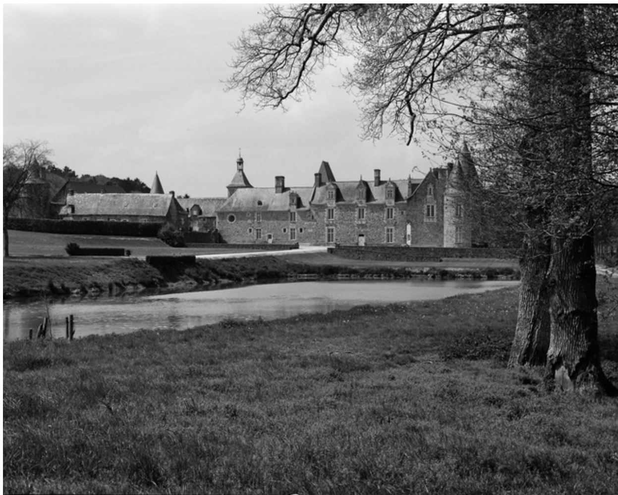
Vue de situation sud-est.
