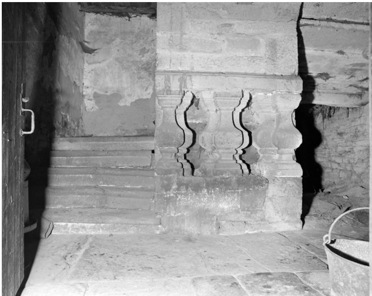
Vue de l'escalier intérieur du logis
