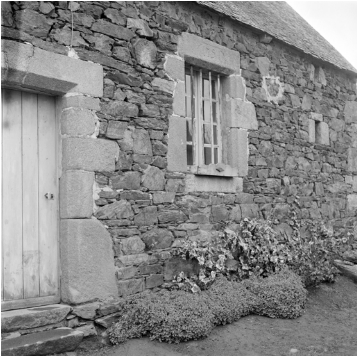
Façade antérieure, détail : fenêtre datée (état en 1974).
