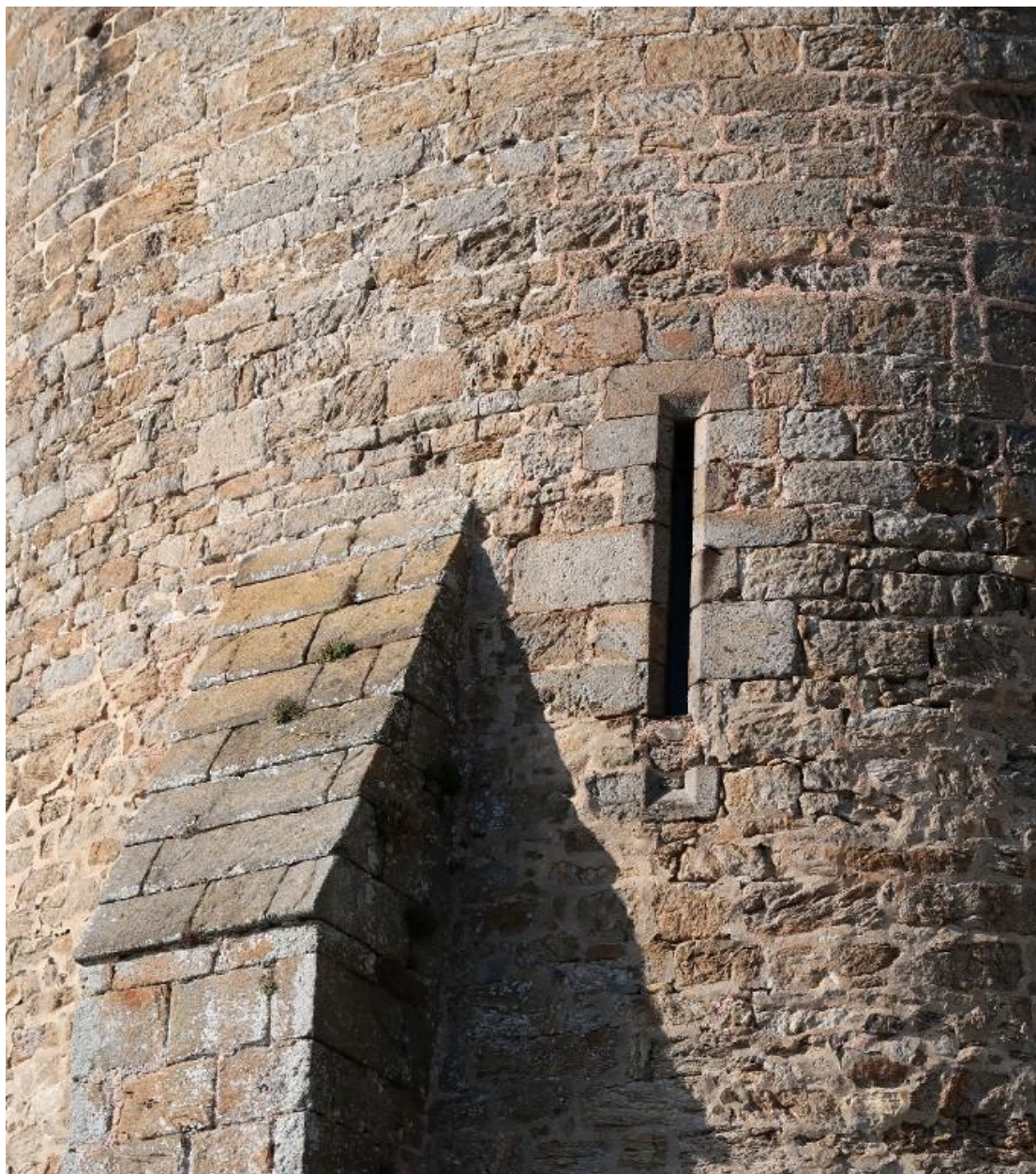
Vue de l'arbalétrière-canonnière sud (dépourvue d'arc de décharge) du rez-de-chaussée de la tour ouest. A gauche, contrefort sud en pierre de taille
