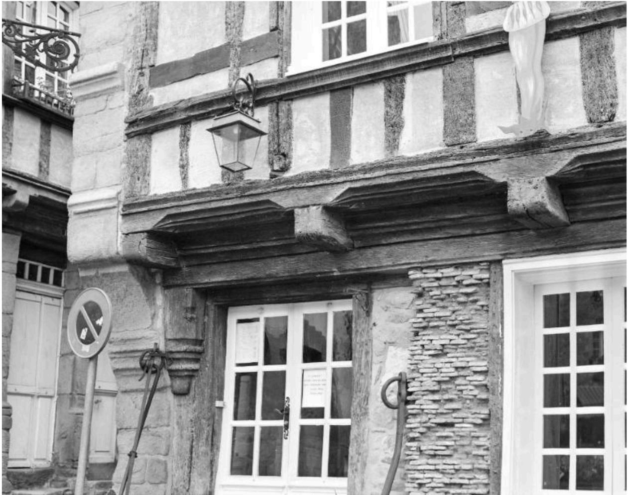
Elévation antérieure, détail de l'encorbellement inférieur, à consoles et entretoises moulurés
