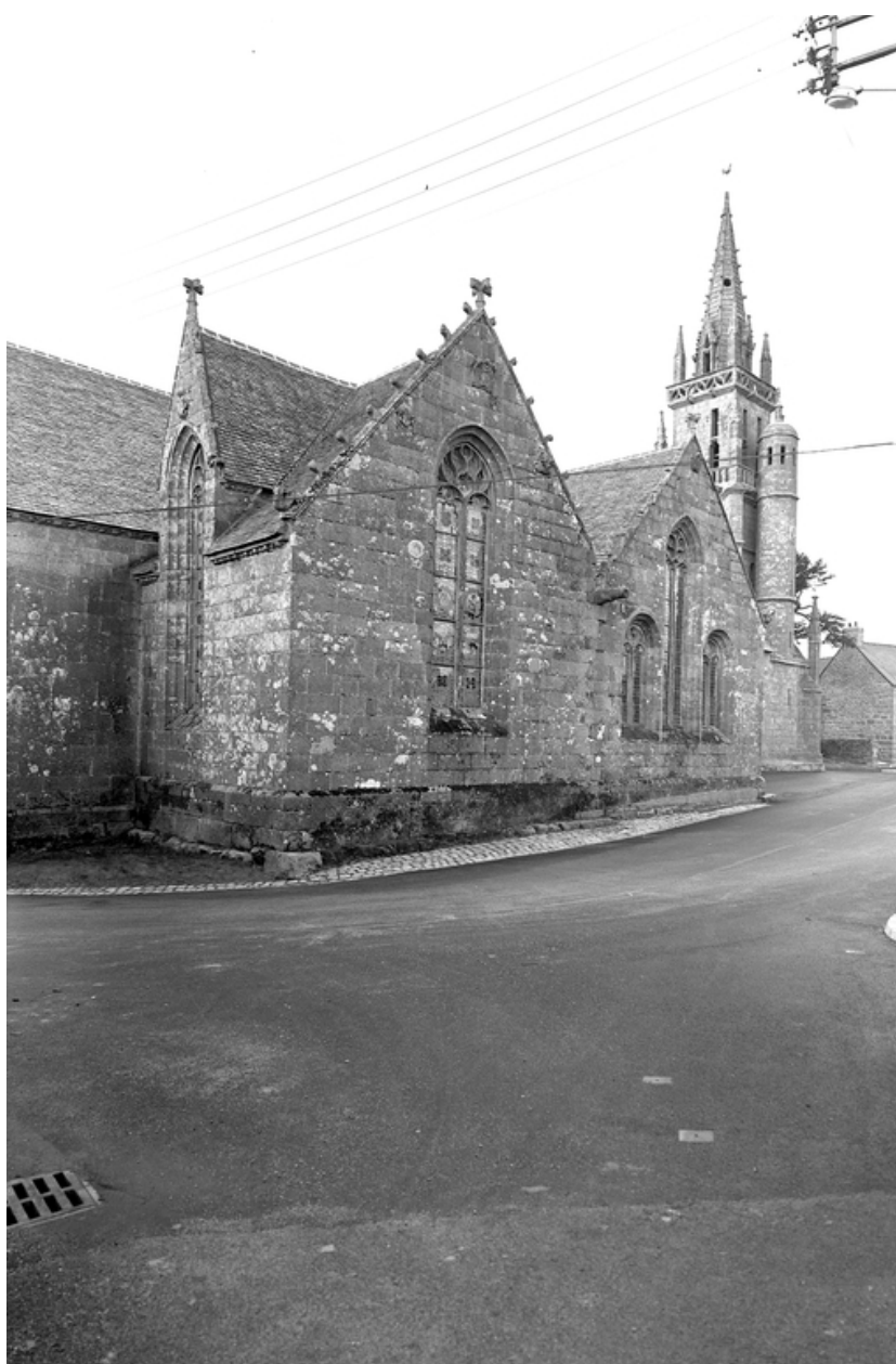
Vue de situation prise du nord est
