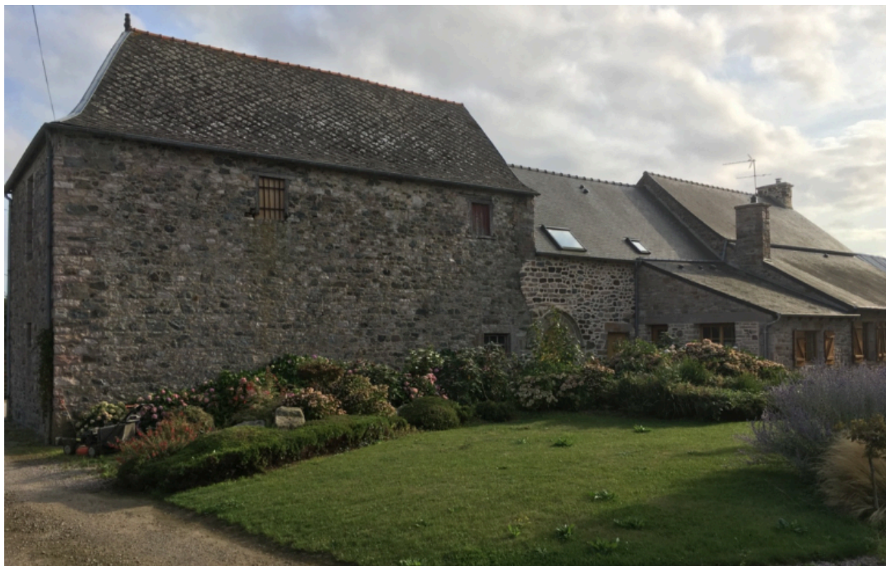
Vue nord de La Moinerie du Portail
