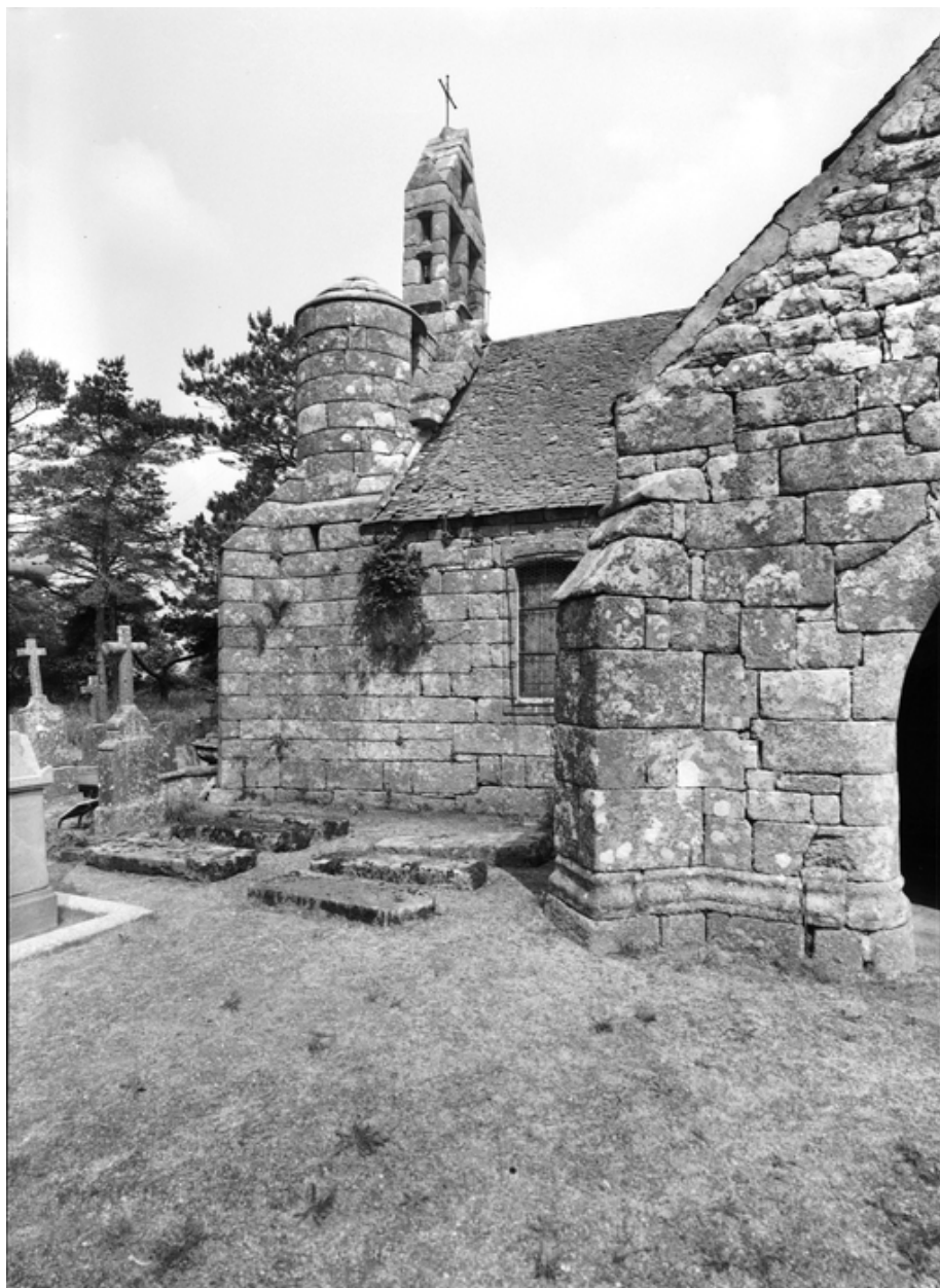
Clocher : vue sud est
