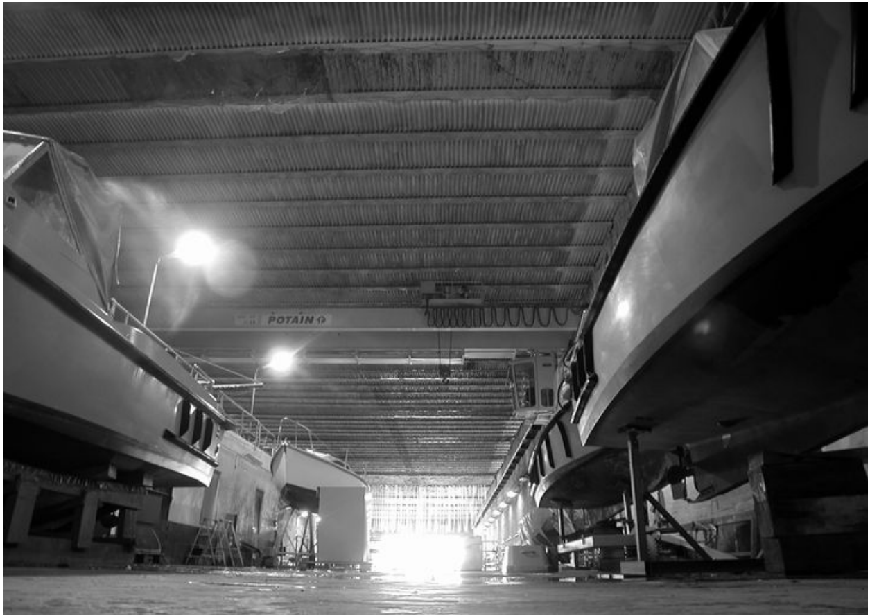
Vue intérieure de la base de sous-marins : première alvéole servant au stockage de bateaux (2004)
