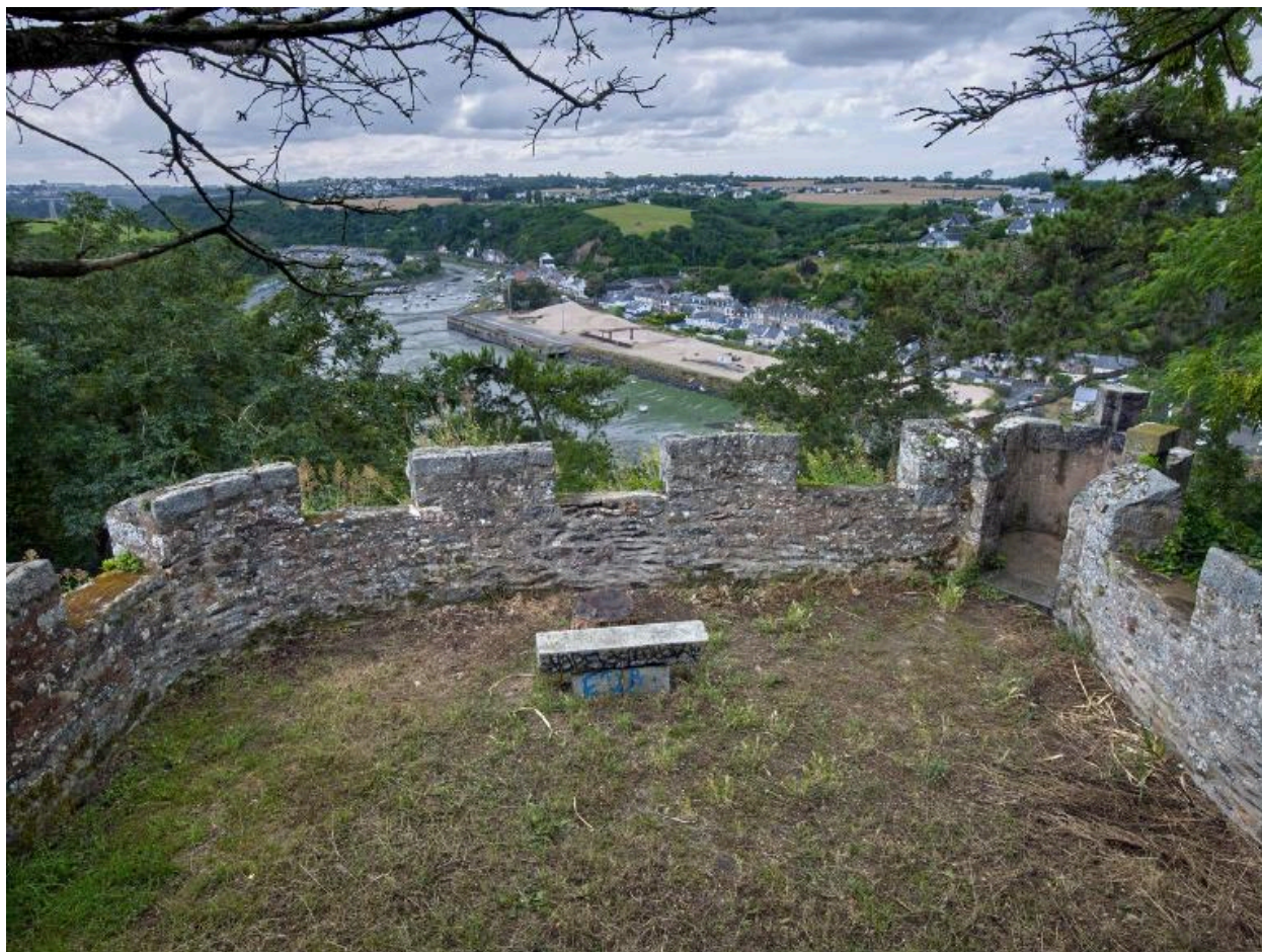
Vue du belvédère de jardin dit Tour Malakoff : la terrasse et le parapet crénelé dans le style néo-gothique. En arrière-plan, le Port du Légué
