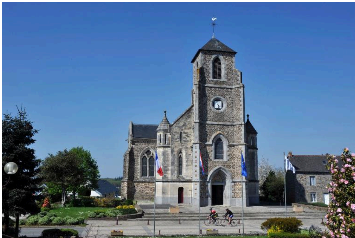
Vue générale : côté Sud
