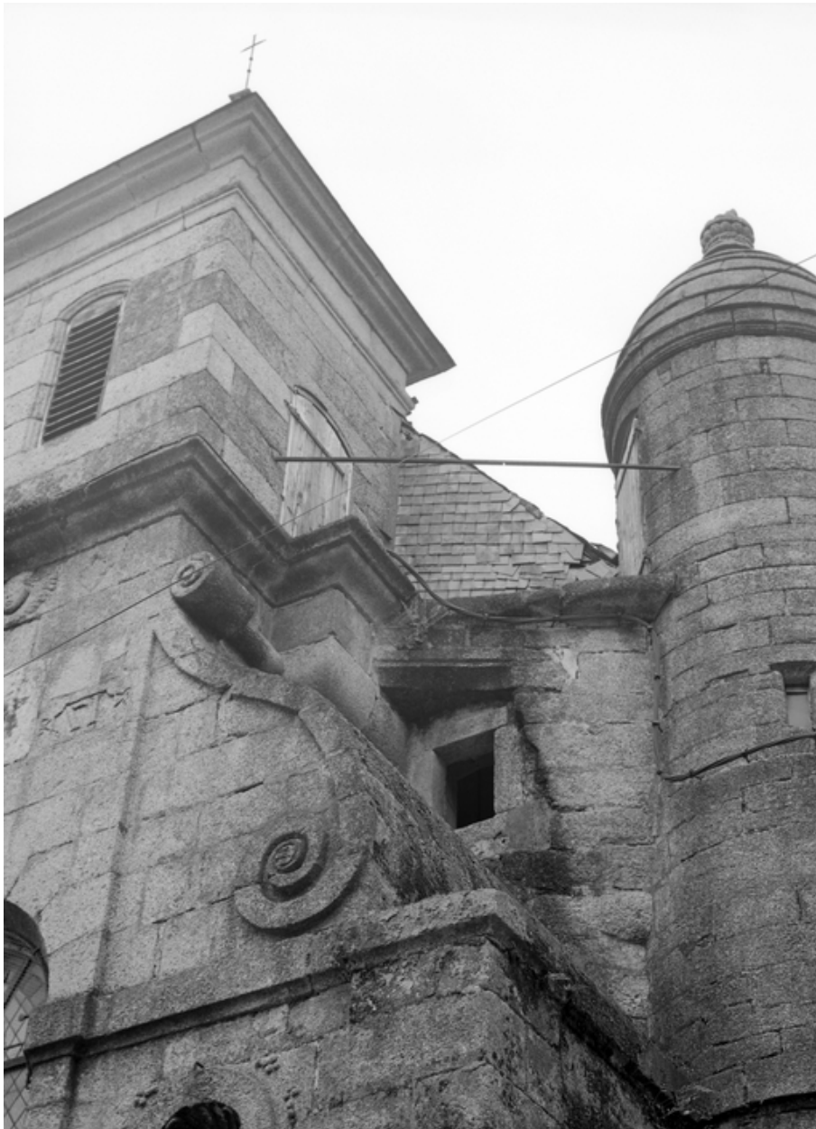
Détail de la tour d'escalier et du clocher.
