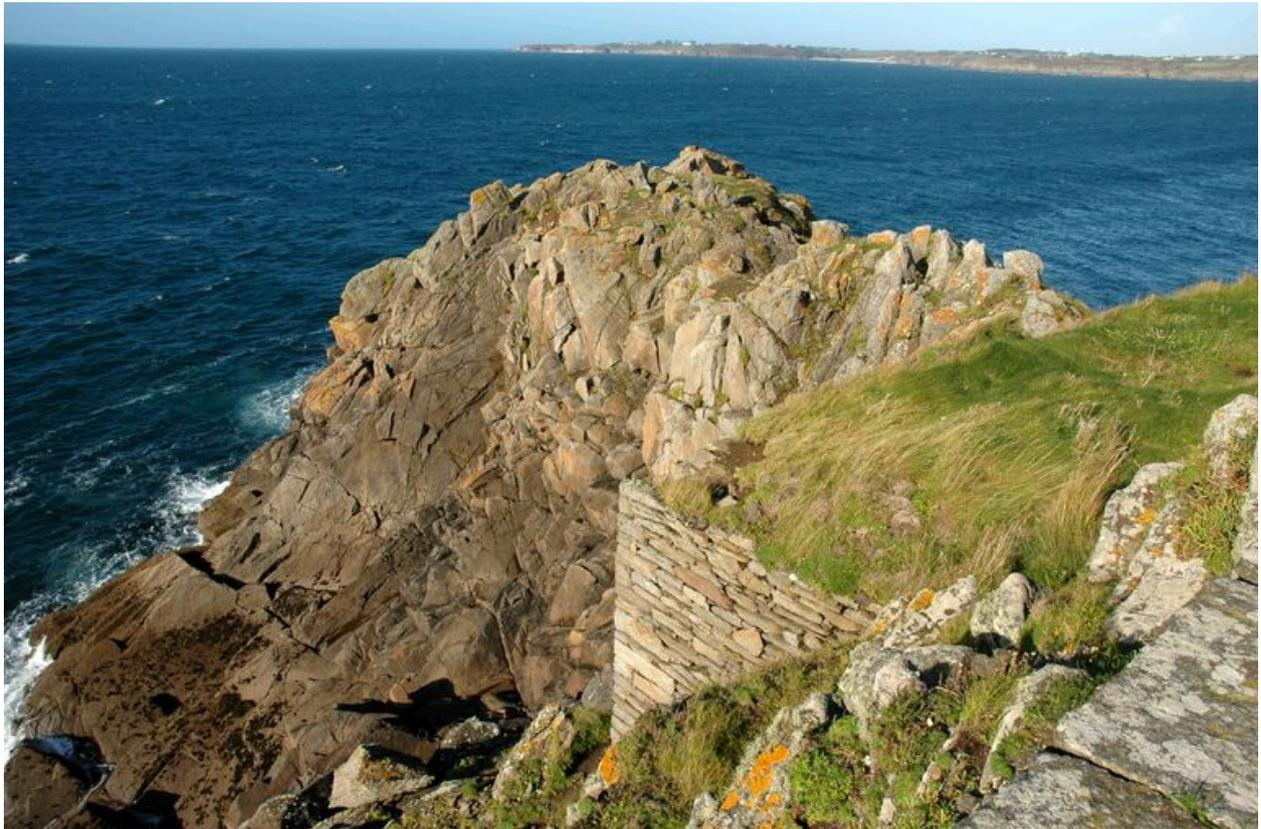
Extrêmité septentrionale de l'îlette : massif de maçonnerie soutenant le parapet de la batterie haute
