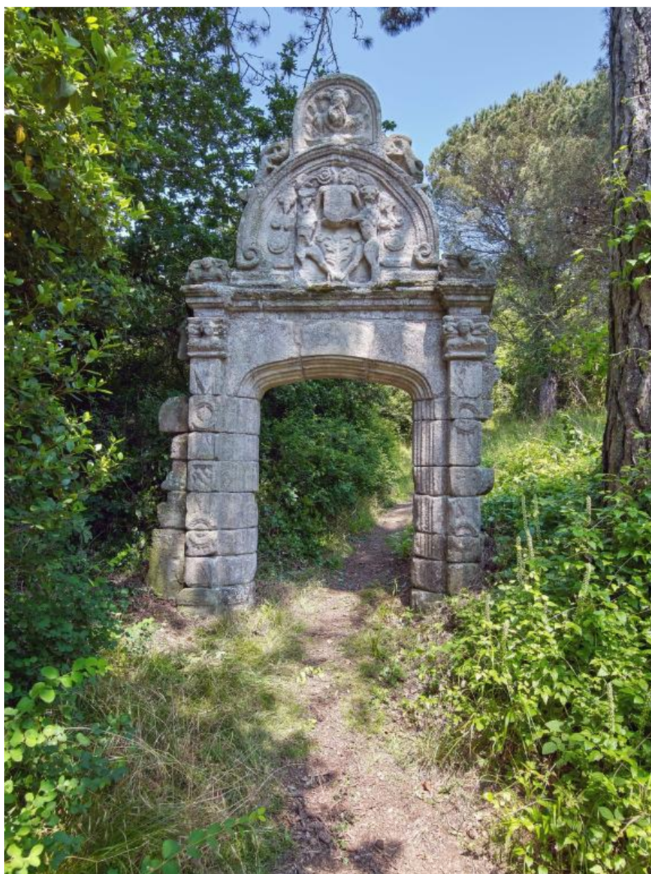
Vue générale de la porte ornementale basse de style Renaissance : élévation Sud-ouest
