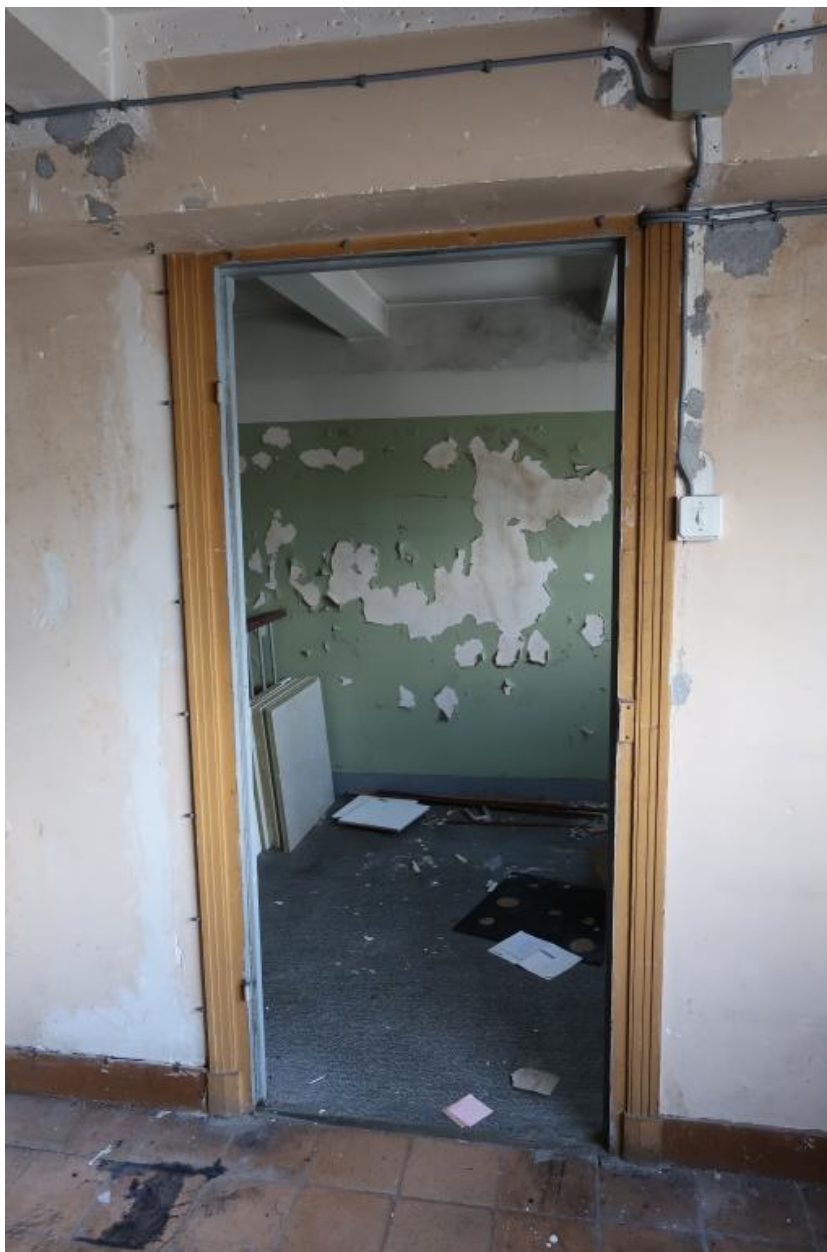
Encadrement de porte depuis le toit terrasse vers le palier du dernier niveau
