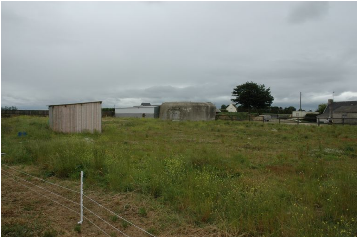
Vue de situation du bunker-casemate sud (état en 2008)
