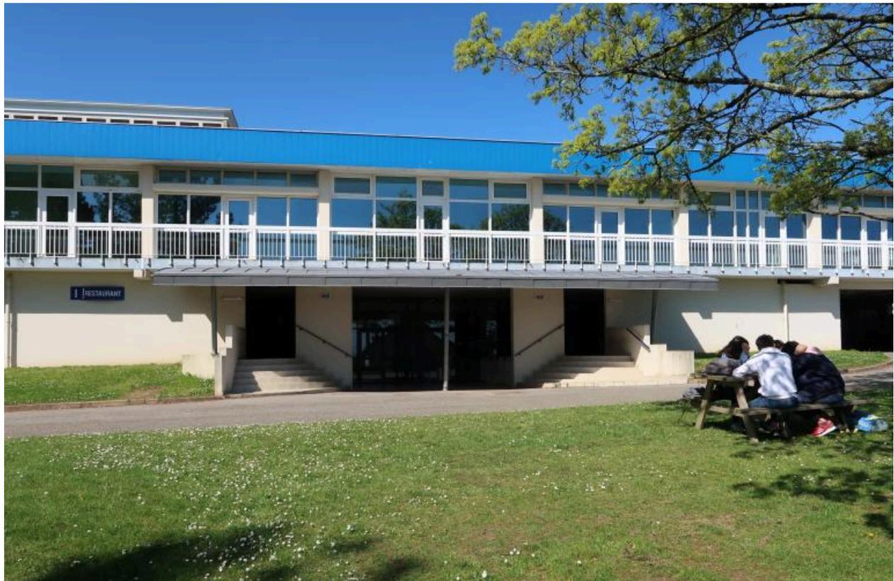
Façade sud du service de restauration. Les entrées des selfs, situées en rez-de-chaussée. Les trois côtés est, sud et ouest du restaurant scolaire sont intégralement vitrés et ouvrent sur un balcon continu.
