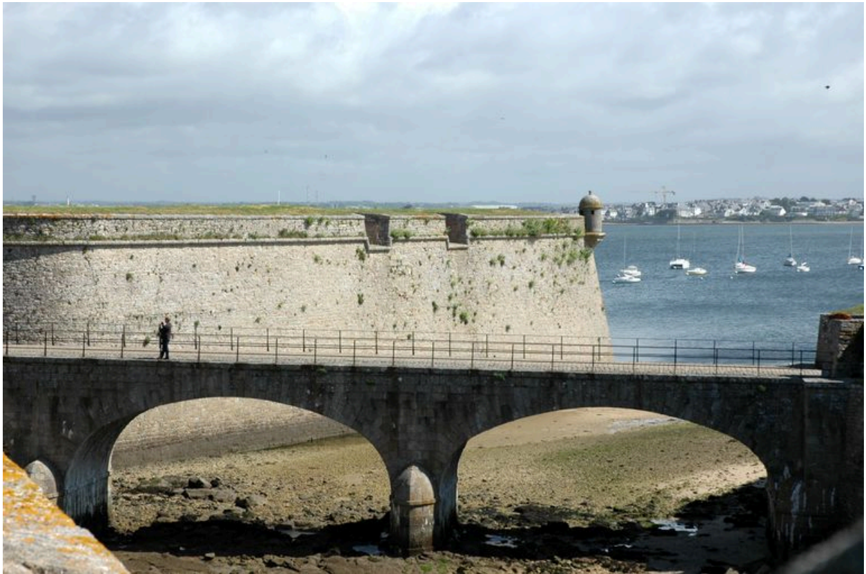
Vue de la citadelle de Port-Louis : grand pont en granite permettant de franchir le canal. En arrière-plan : le bastion Dumourier et son échauguette
