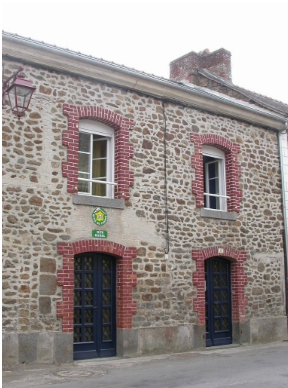
Vue générale ouest
