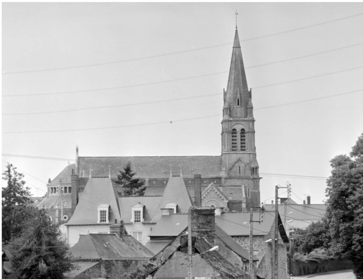
Elévation est : vue générale
