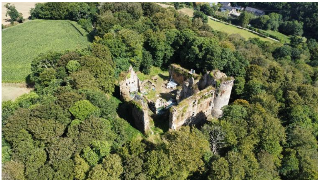
Vue aérienne oblique depuis le sud
