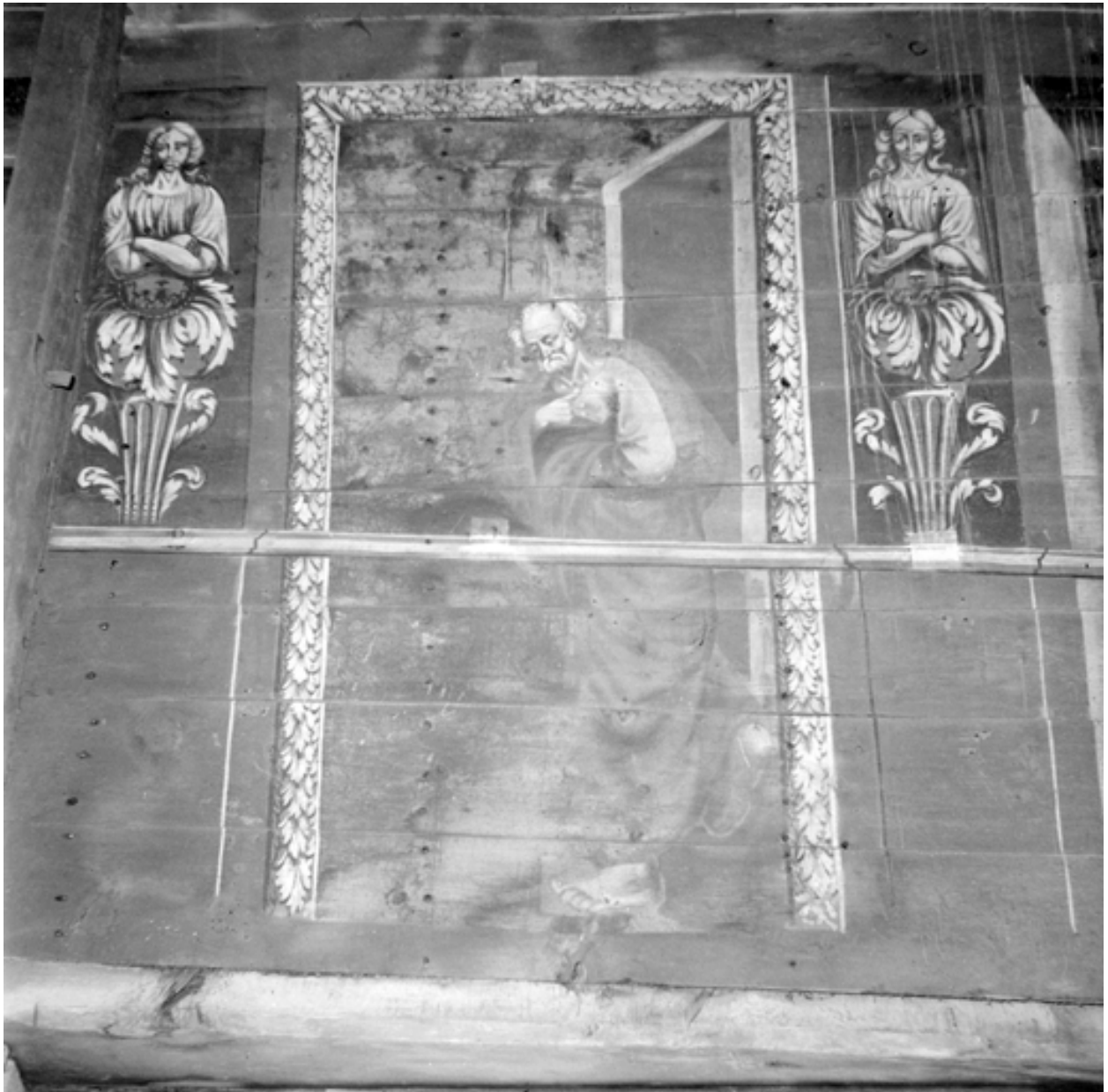
Voûte, détail du panneau I au sud de l'ouest à l'est.
