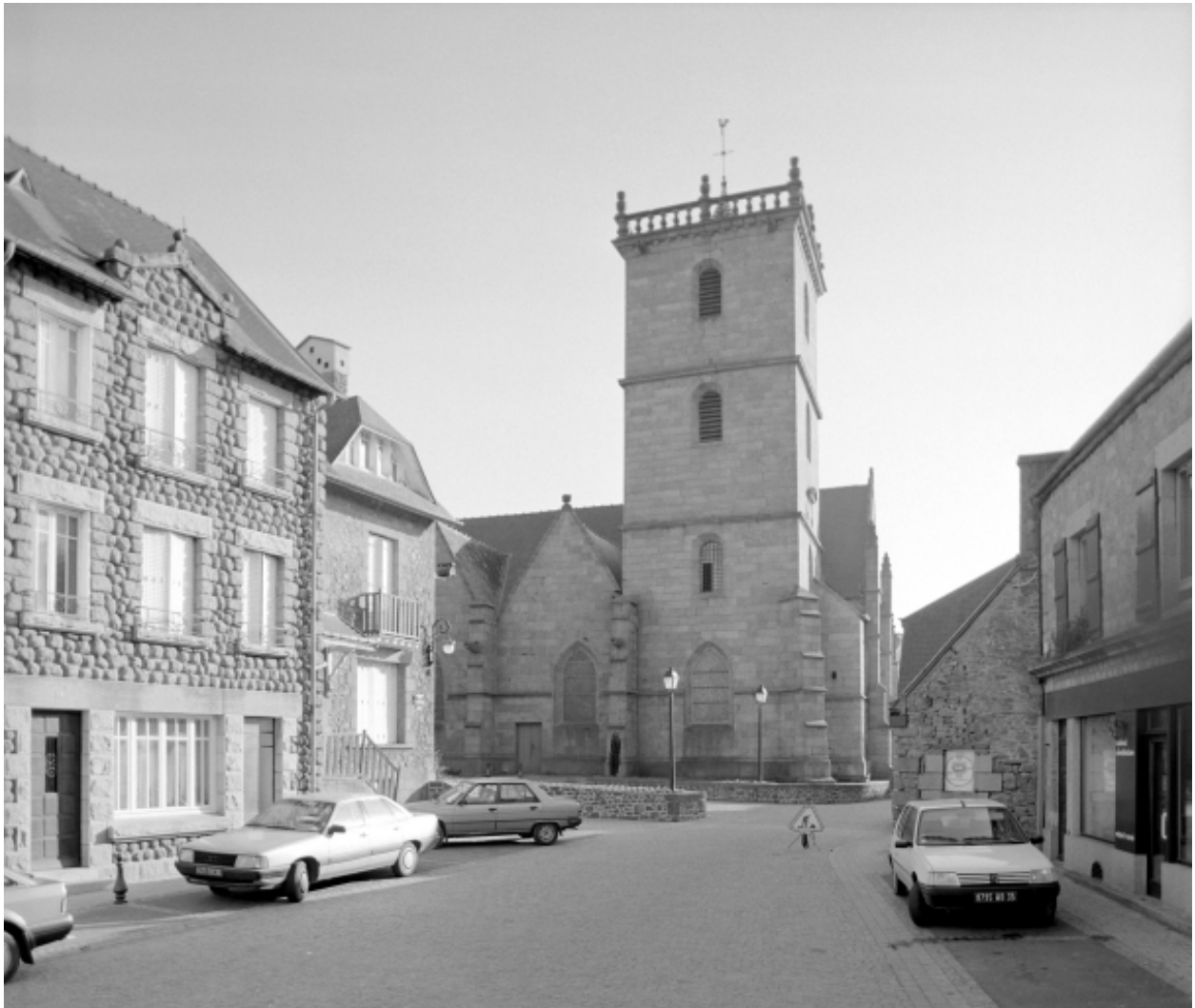
Elévation Nord, partie Est : vue générale
