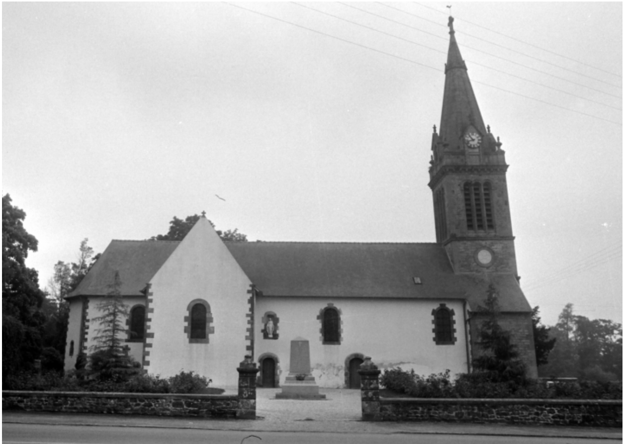
Vue de face du côté nord
