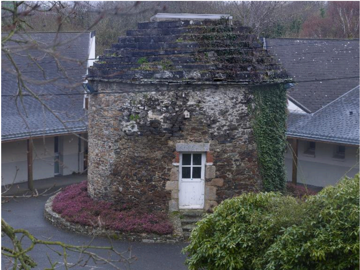
Colombier à l'ouest du château. Vue générale
