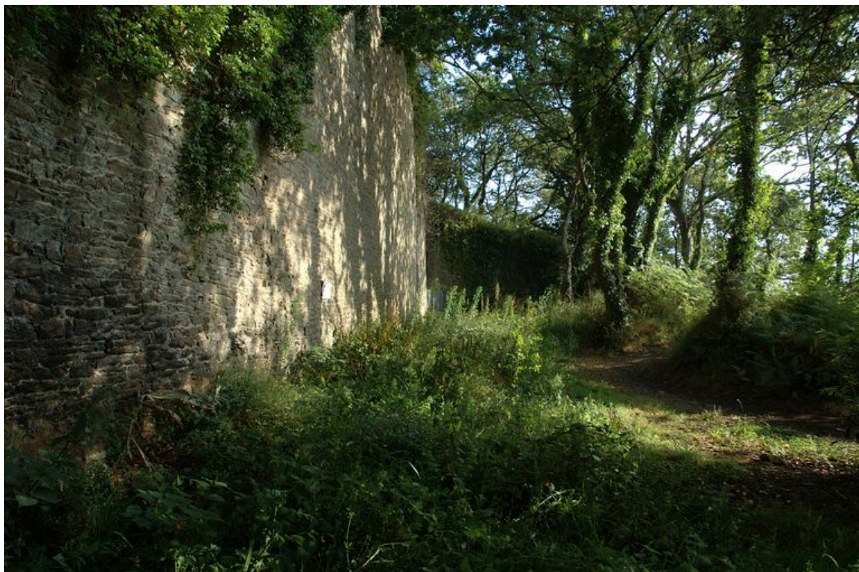
Vue de l'enceinte du fort de mer
