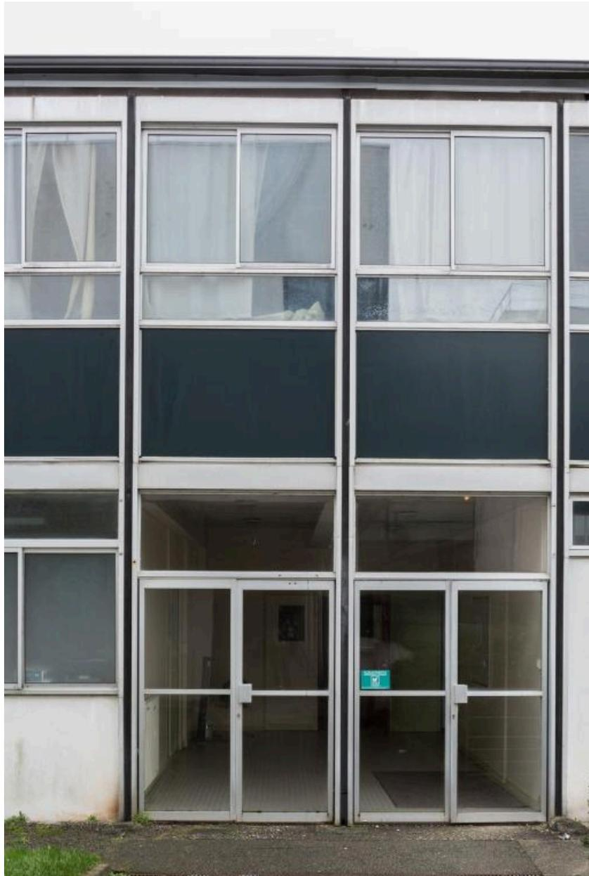
Détail de la façade à structure métallique des anciens ateliers, au niveau de l'entrée.
