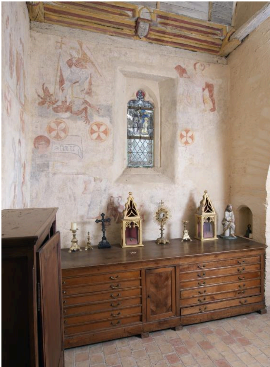
Eglise Saint-Melaine, vue intérieure de l'élévation est de la sacristie Saint-Gilles
