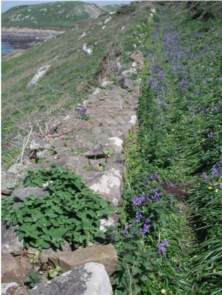
Vue du muret en pierres sèches avec remplissage en pierres de tout-venant : 70 à 80 cm de ht et 70 cm de large
