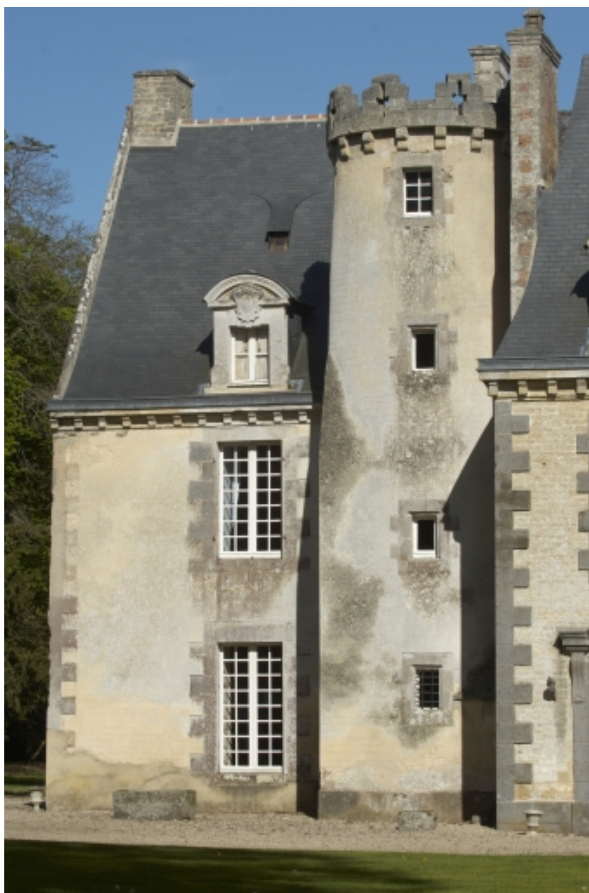
Logis, façade arrière, détail
