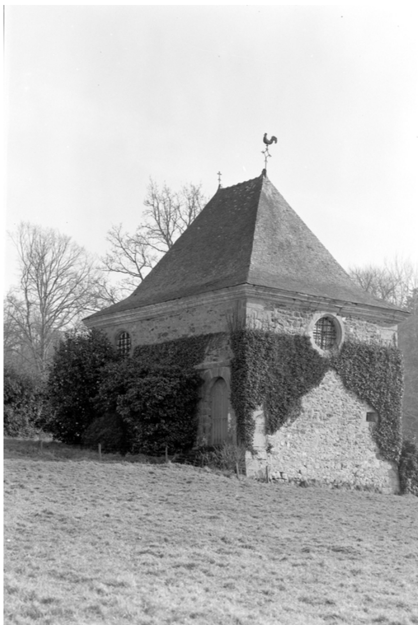
Chapelle : vue générale nord-ouest
