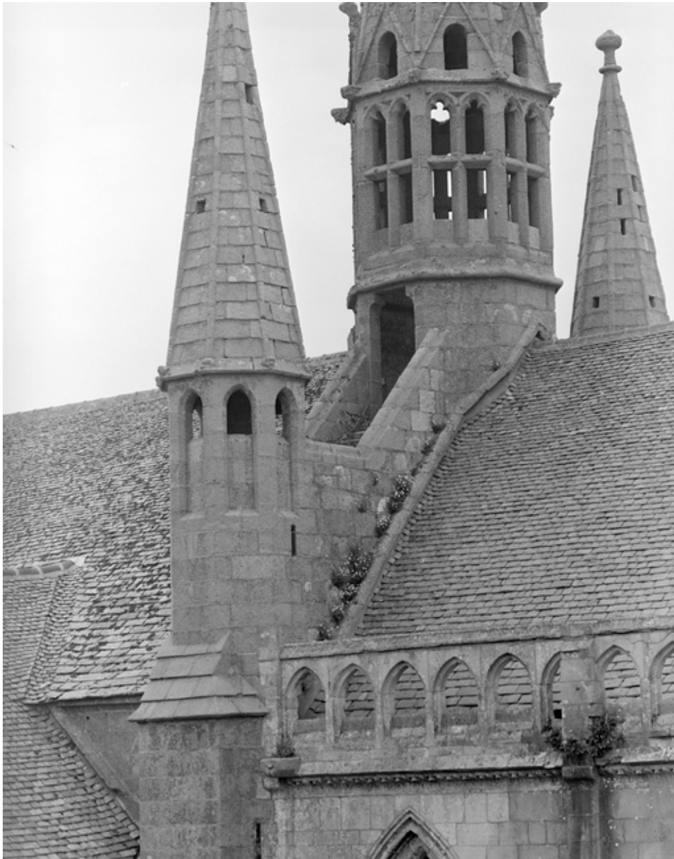
Mur nord, détail contrefort et clochetons
