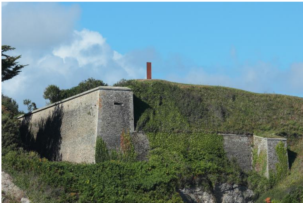
Le Palais, enceinte urbaine, courtine 18, extrémité nord-est.
