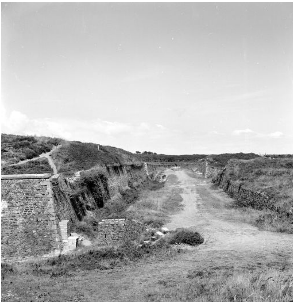
Vue d'ensemble dans l'axe du fossé des lignes de Quéléren en 1969 : front 1 et 2. A gauche : saillant du demi-bastion 1, à droite : contrescarpe du demi-bastion. Au fond : demi-lune n° 6
