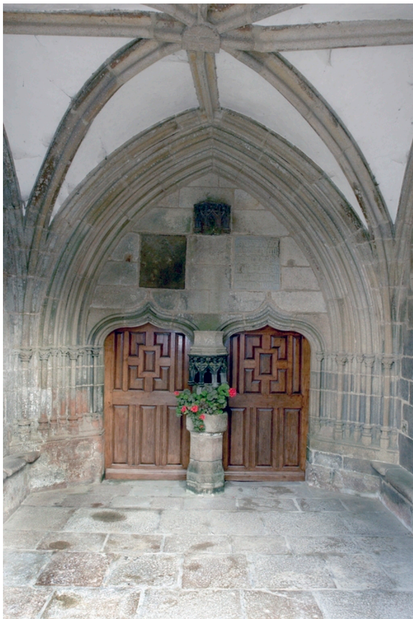
Intérieur du porche sud
