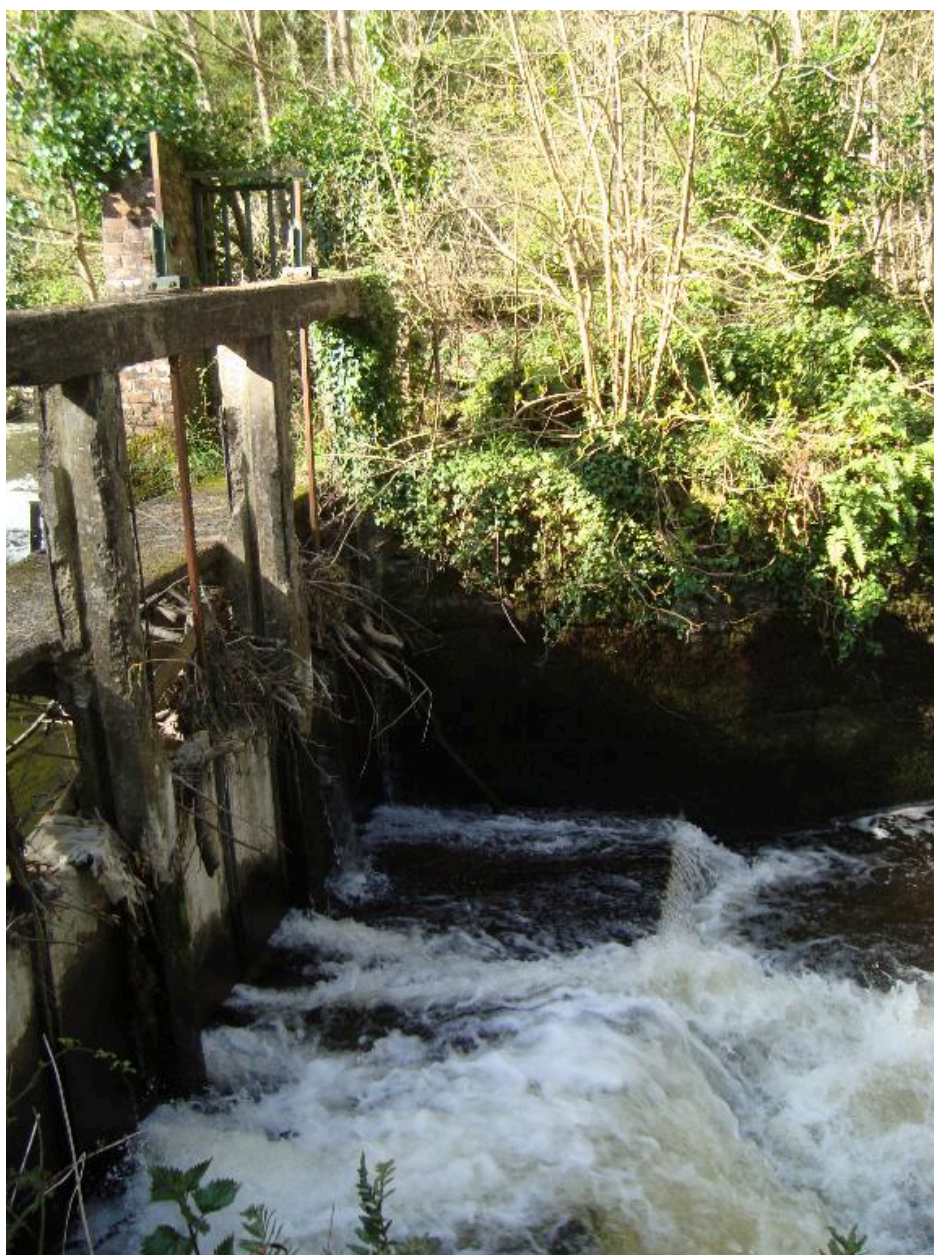
vanne du seuil situé en aval de la papeterie
