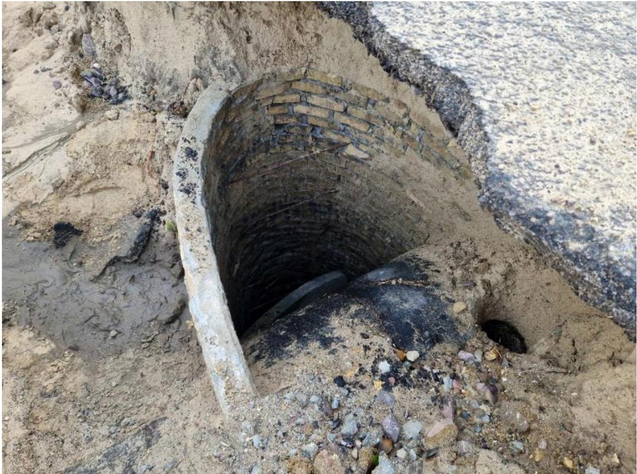
Vue du puits de la sortie de secours. Le puits est en maçonnerie de brique montée au ciment avec échelon en fer à béton ; il est partiellement obstrué
