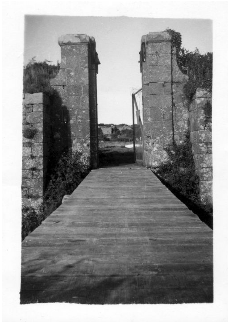
Landéda : fort Cézon, vue de la porte monumentale et du pont dormant en bois, photographie du milieu du 20e siècle (?) (collection association Cézon)
