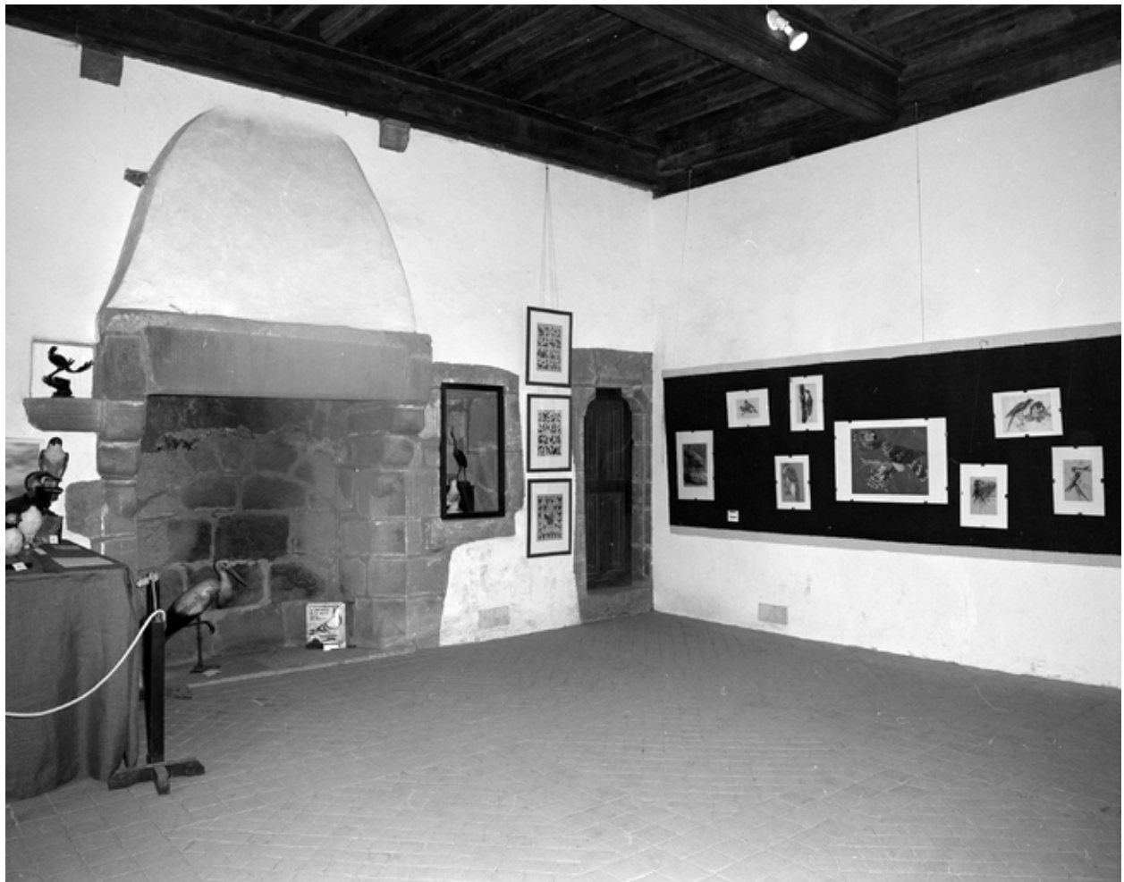
Vue de la chambre nord-ouest au deuxième étage : cheminée à hotte pyramidale, niche murale et porte donnant sur le chemin de ronde (état en 1974). Cette pièce était à l'origine sous charpente
