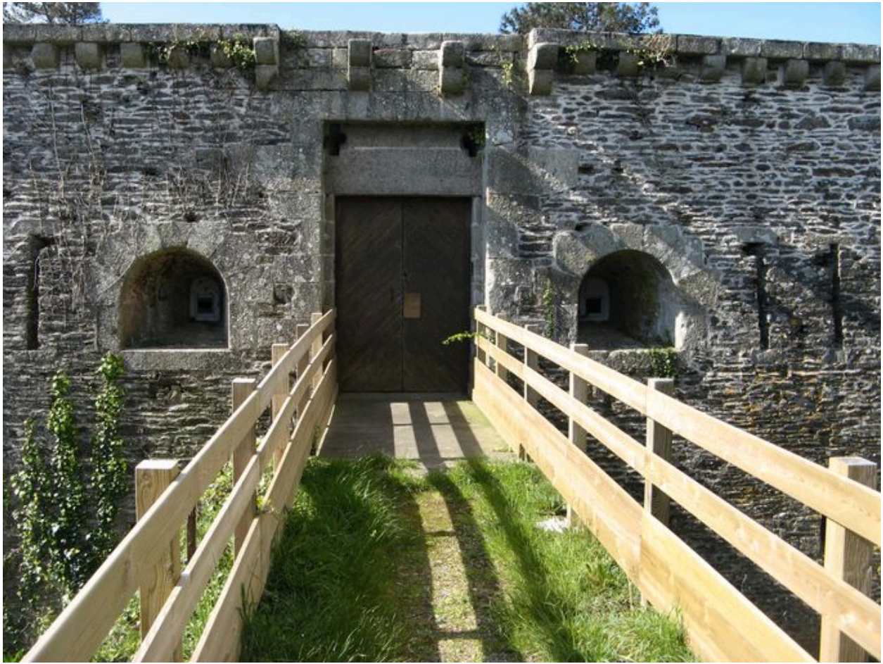
Tour-réduit de la pointe des Espagnols
