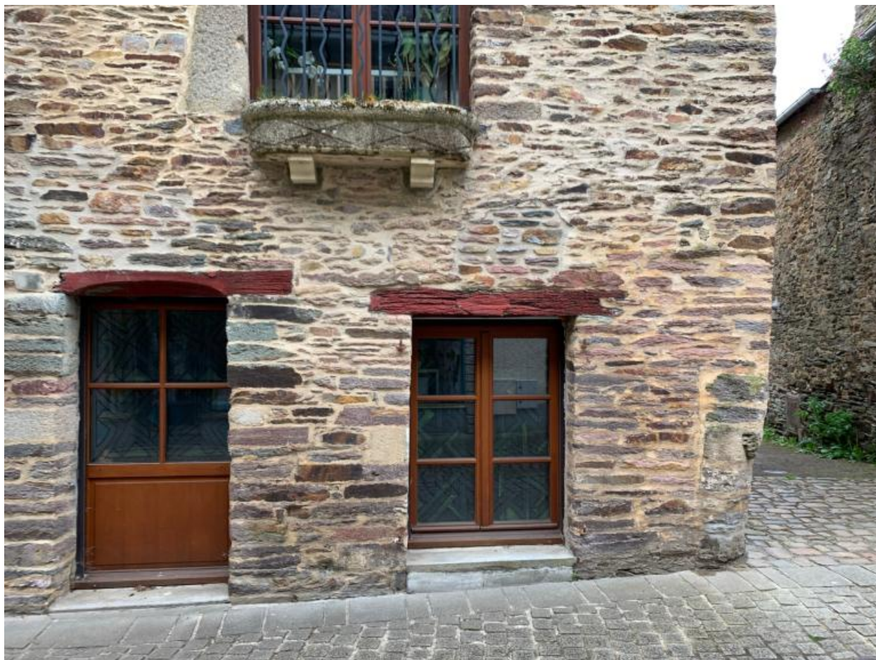
Façade nord. Rez-de-chaussée, partie est
