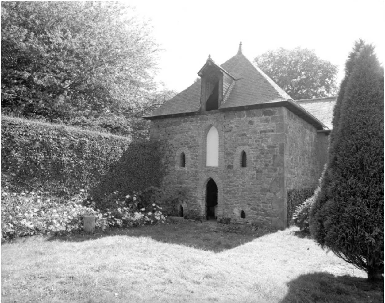
Communs au nord, chapelle, face est, vue générale.
