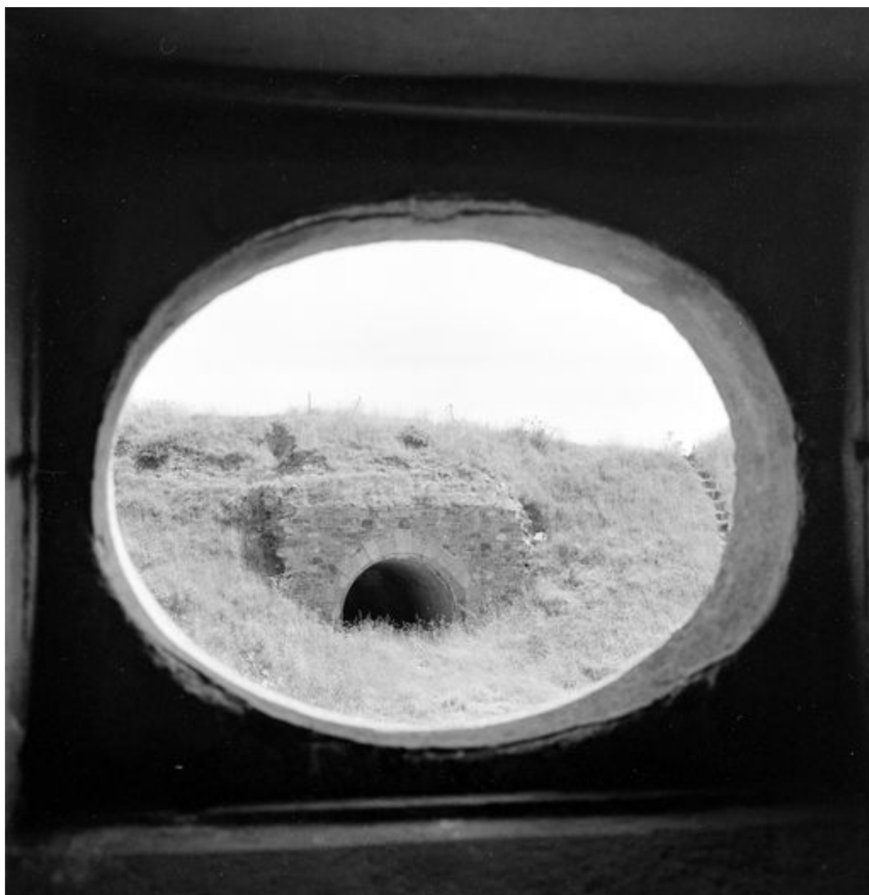
Vue d'un oculus des casernements (état en 1969)
