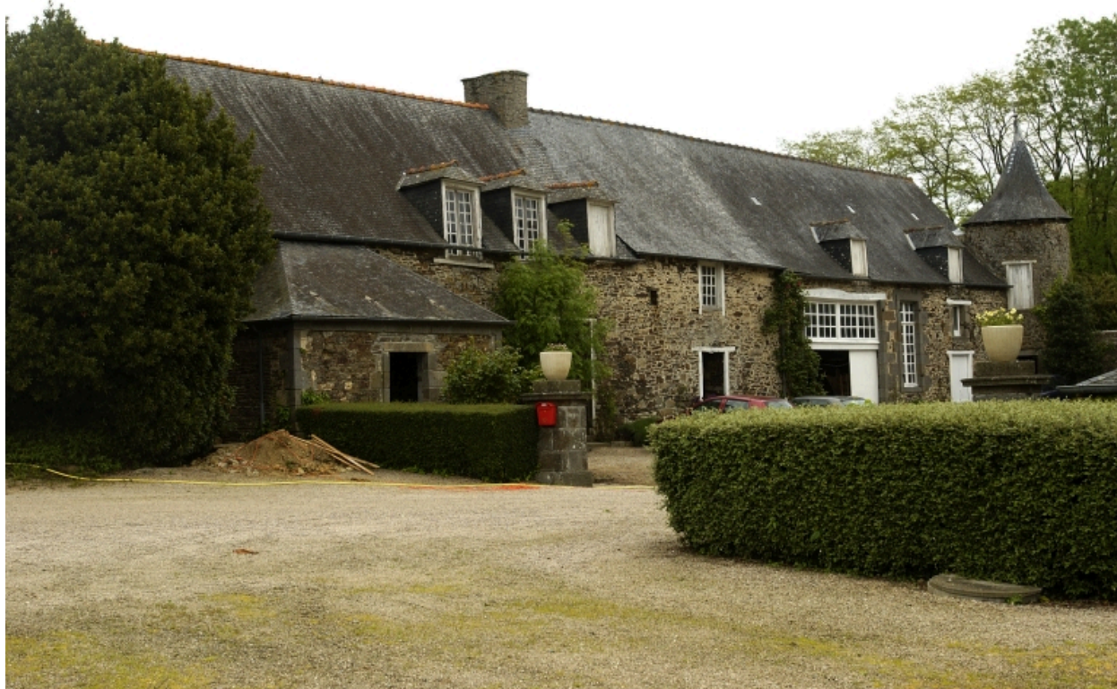
Communs ; vue générale sud ouest
