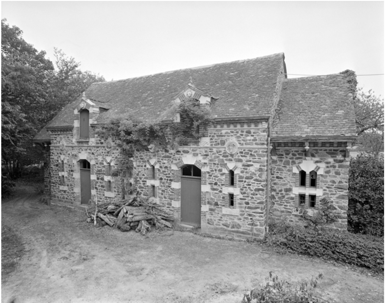
Communs : vue générale du bâtiment nord-est.
