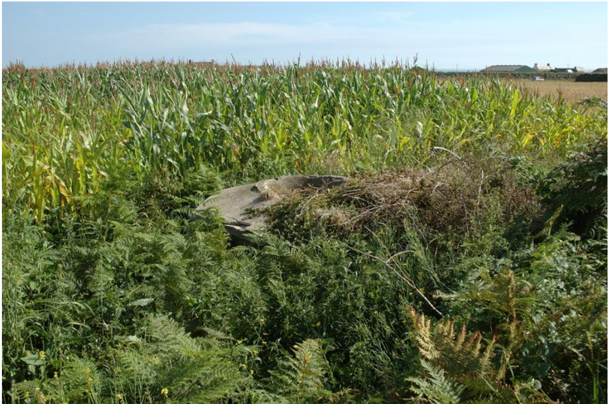
Vue d'un poste d'observation et de tir bétonné dit "Tobruk-Stand"- en défense rapprochée (n° 2)
