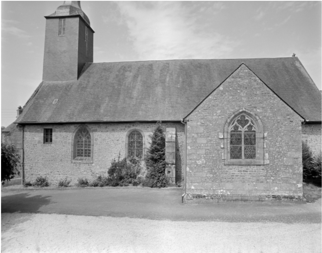
Elévation Sud-Ouest : vue générale
