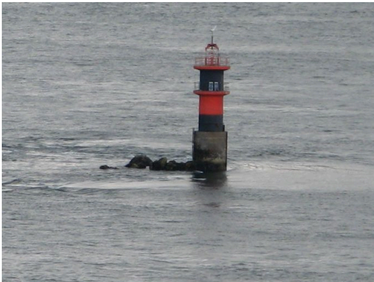
Vue générale de la tourelle de la Roche Mengant
