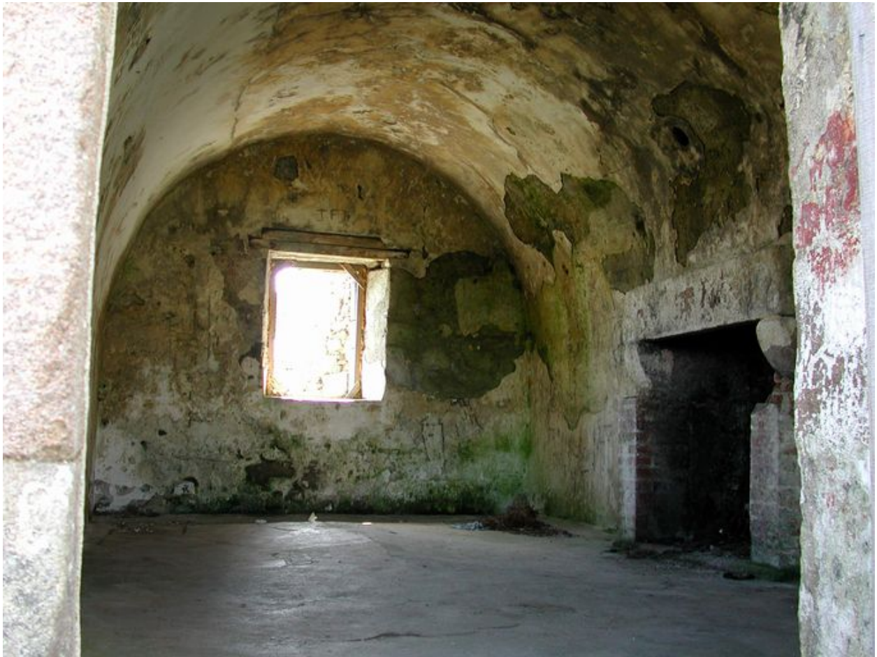
Vue intérieure du corps de garde (état en 2002). Le corps de garde est voûté ; son mur gouttereau ouest (arrière) accueille une cheminée
