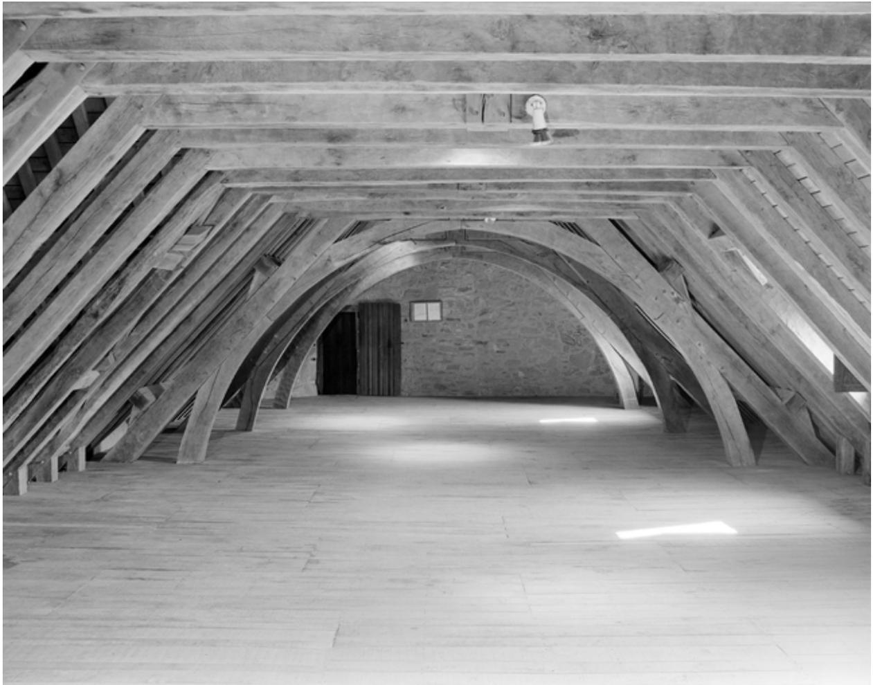
Vue de la charpente : espace central (état en 1989). Le plancher est un ajout : à l'origine, le deuxième étage était sous charpente
